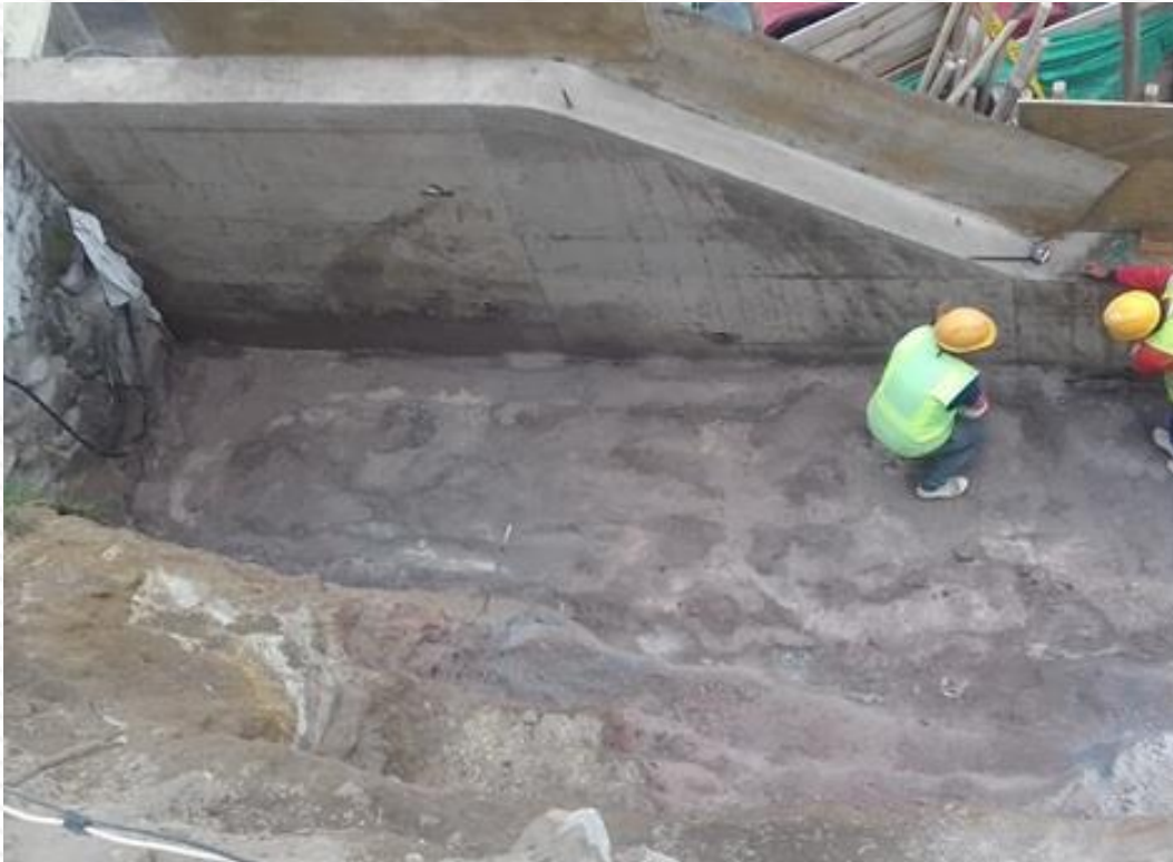
Taludes y graderíos la Yahaira
