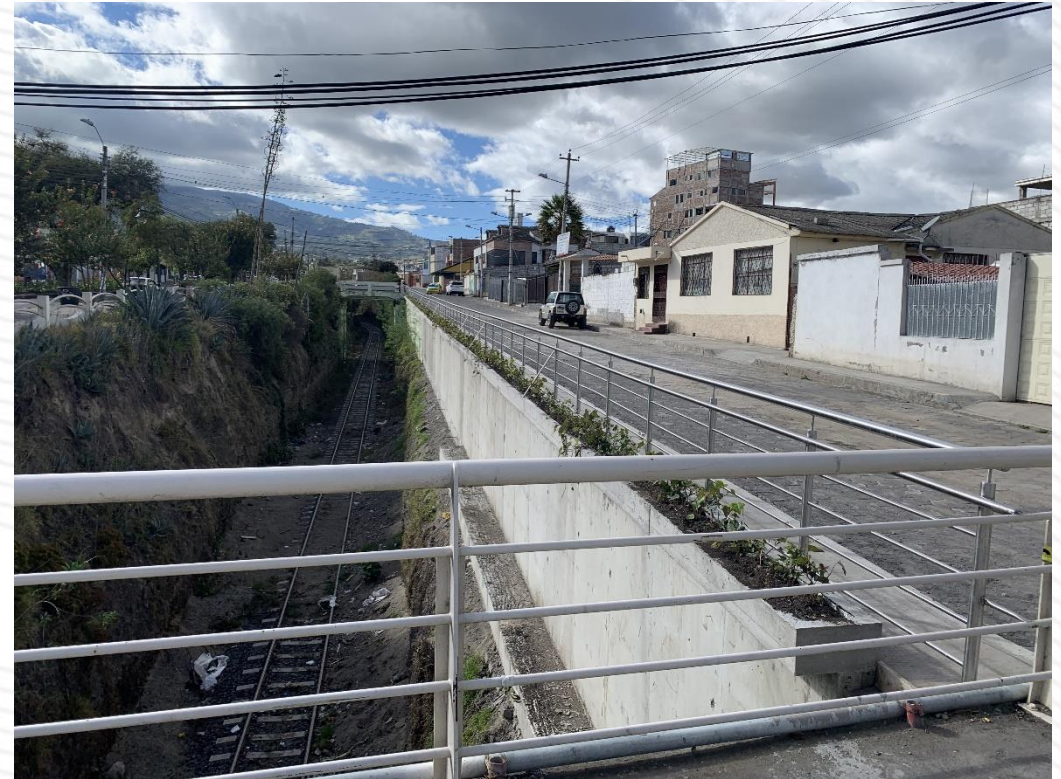
Muros varios sectores
